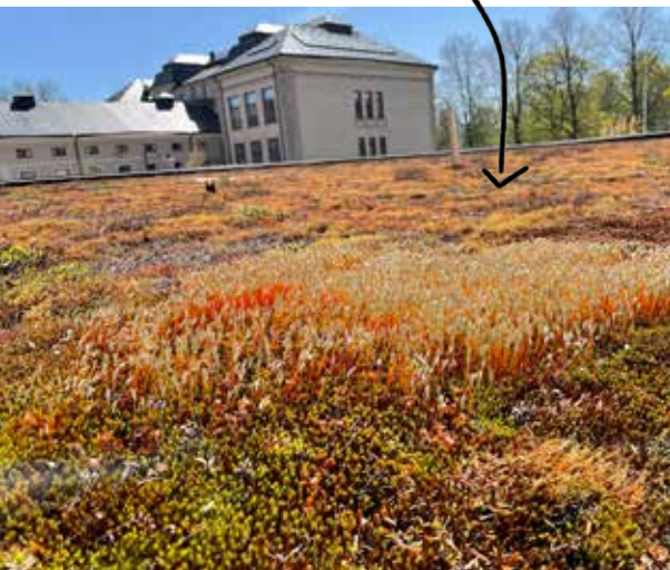
SEDUMTAK PÅ KAROLINSKA GYMNASIET
